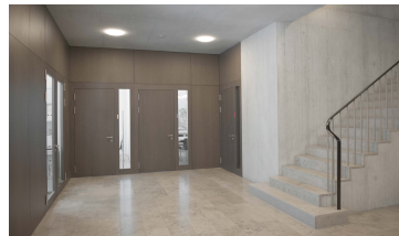
Eingangshalle Der rohe Sichtbeton kontrastiert mit den gebeizten Eichenholzfächeln.
