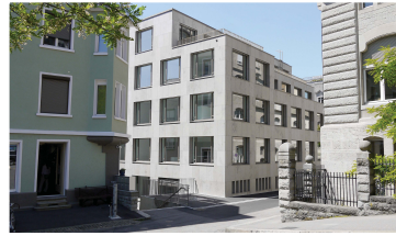
Hochfarbstrasse Gesteifer Dachstuhl mit Dachaufbauten in den Gebäudecken © Foto: Tobias Peter
