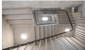
Treppenhaus Der Sichtbetonkern beherbergt die vertikale Erschliessung und alle Medien.
